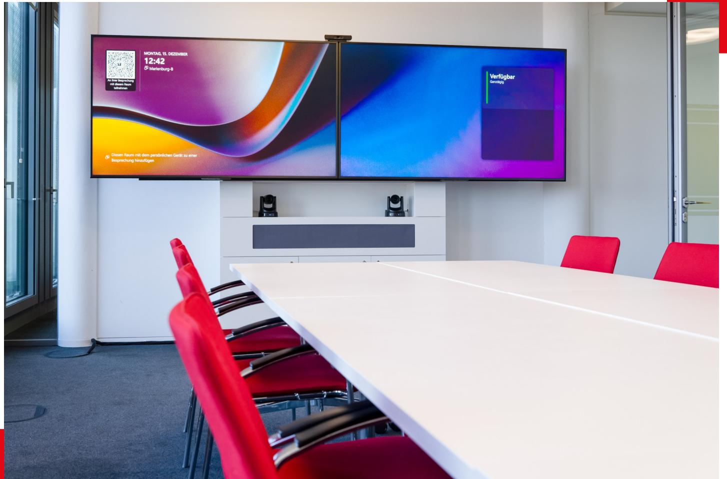
„Marienburg B“ wurde als professioneller Microsoft Teams-Room umgesetzt. Zwei Sony Displays, installiert auf einer maßgefertigten Jahn Medienstele, bilden das visuelle Zentrum. Die Videotechnik besteht aus zwei PTZ-Kameras und einer 120° Weitwinkelkamera; ein Shure Deckenmikrofon sorgt für gleichmäßige, hochwertige Sprachaufnahme. Für die Be-
